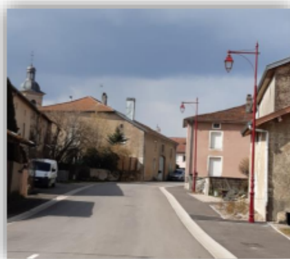
Enfouissement des réseaux à Sandaucourt
