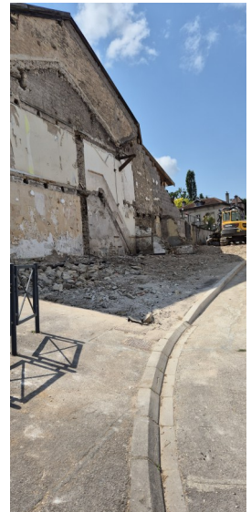
Élargissement de la rue Saint-Maurice après démolition. Pose des bordures de trottoir
